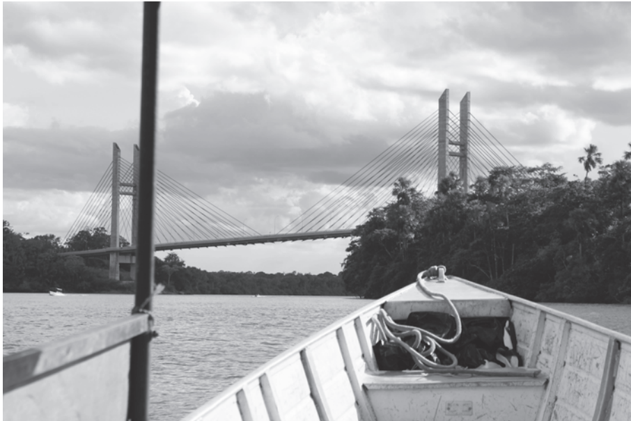
Le pont sur l'Oyapock, entre Guyane et Brésil. Photographie H el ene Ferrarini, octobre 2014.
